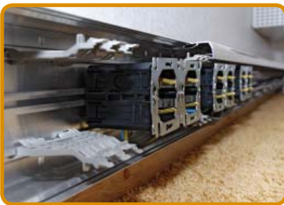
CLOSE-UP BINNENWERK HMS WANDCONTACTDOZEN
