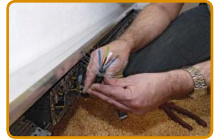
CLOSE-UP EN DOORSNEDE GESTRIPTE KABEL
