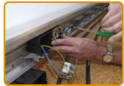
MONTAGE KABELS IN HMS WANDCONTACTDOOS
