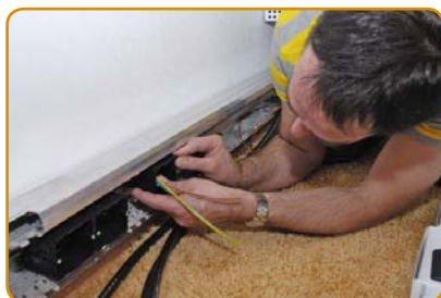
AANBRENGEN VAN INBOUWDOZEN IN WANDRAIL
