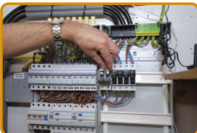
PLAATSEN VAN DE ZEKERINGEN EN ZEKERINGBUSSEN
