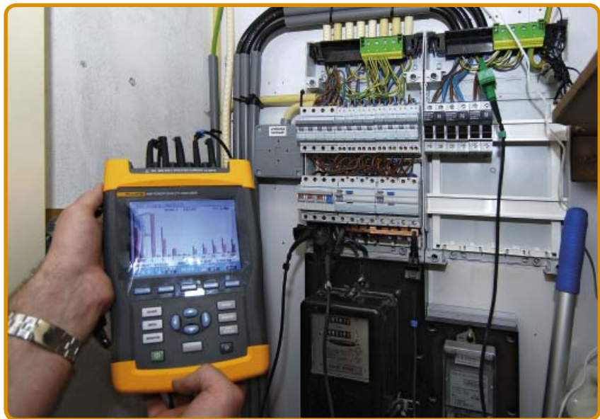
METING VAN DE VERVUILING VAN DE 3 STROOMFASSEN
