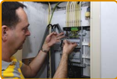
STRIPPEN VAN DE KEMP KABELS AAN METERKASTZIJDE
