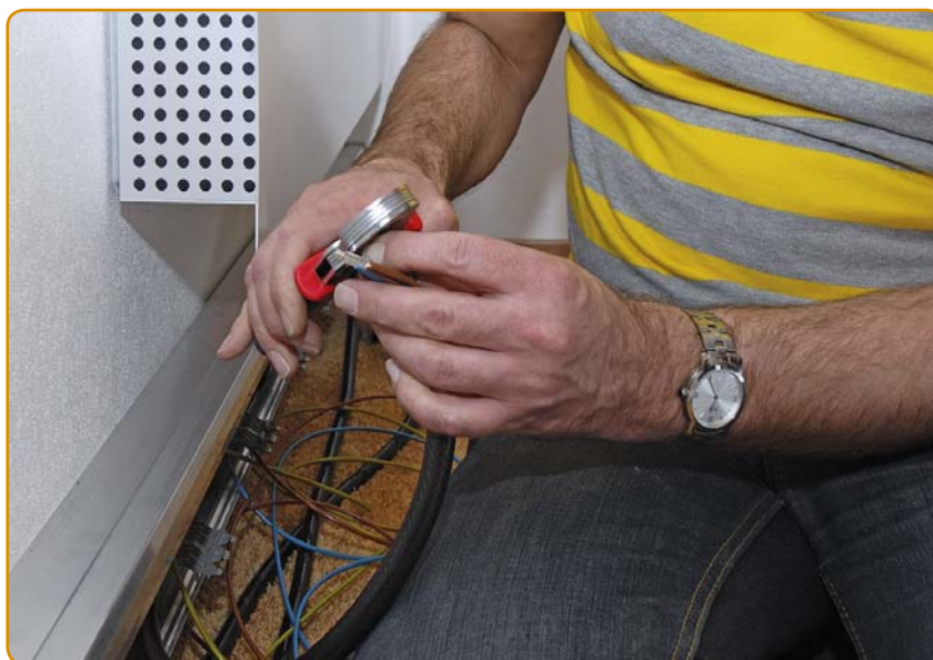
ZILVEREN KRIMPULSJES AANBRENGEN ROND DE GESTRIPT DE DRAADEINDEN
